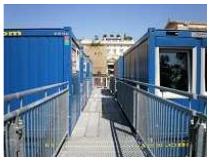
Auf dem Dach der Containerinstallation
